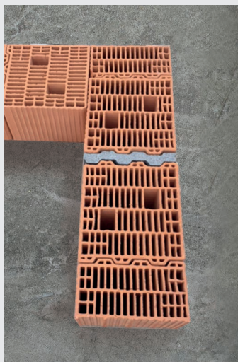
Imagen 17: Replanteo de la primera hilada de un muro de bloque Termoarcilla rectificado.
