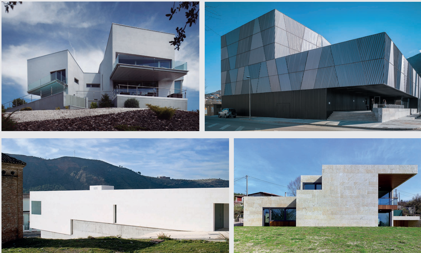
Imagen 1: Obras de muros con bloques Termoarcilla
